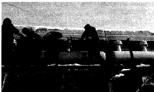
Рис. 6 Центровка штуцеров секций и коллекторов входа и выхода газа АВО.
